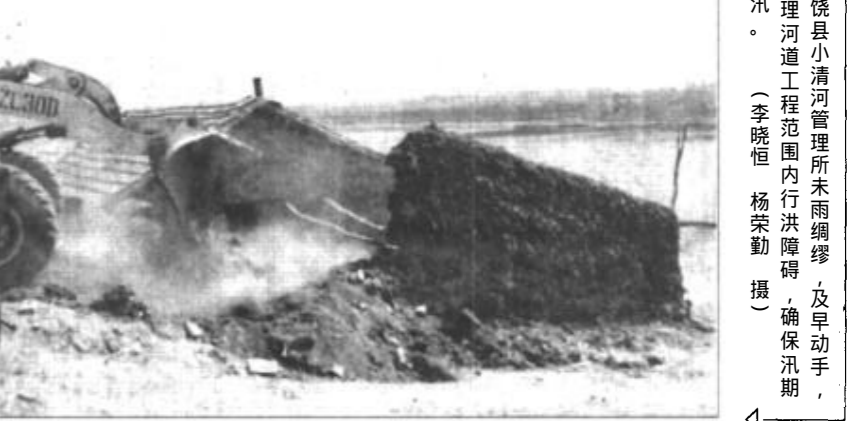
广饶县小清河管理所未雨绸缪,及早动手,依法清理河道工程范围内行洪障碍,确保汛期安全度汛。(李晓明 杨荣勤 摄)
